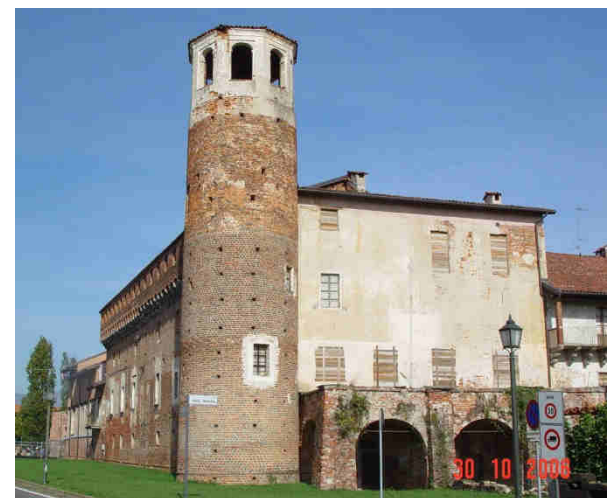
Il castello di Verrone (BI) oggetto di verifica sismica delle marature storiche
