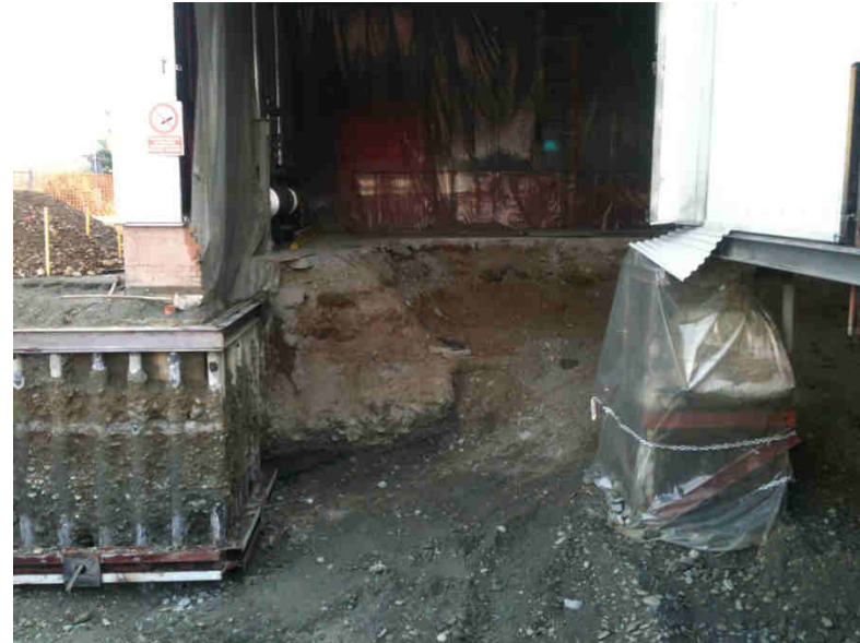
Nuova linea di laminazione dell'alluminio. nello stabilimento di Volpiano. particolare delle opere provvisorie di scavo al di sotto del capannone esistente.
