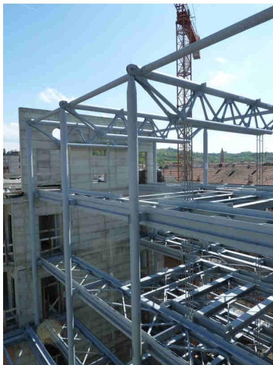
Ferrero S.p.a. Edificio lineare Alba struttura dell'atrio centrale
