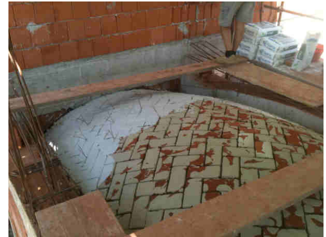
Cascina Strello Leini: realizzazione di nuove volte a vela in mattoni pieni su archi in calcestruzzo
