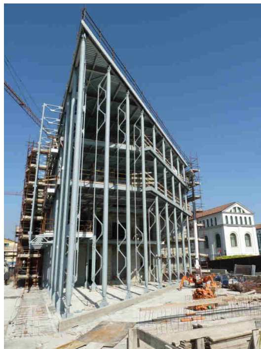
Ferrero S.p.a. Edificio lineare Alba - struttura della punta del fabbricato
