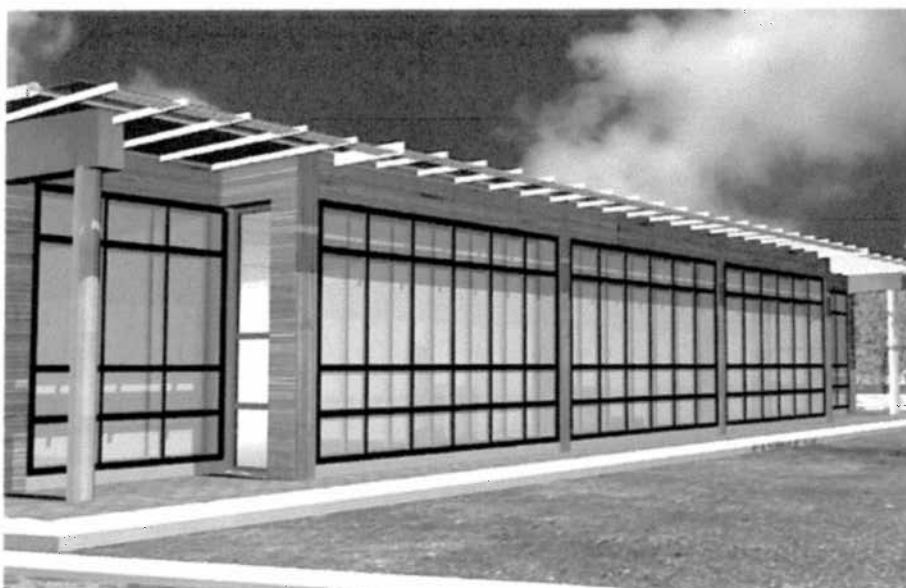
Nuovo Centro per l'Infanzia in Borgaro Torinese: Particolari facciate : Serramenti a doppia pelle, brise soleil in profilati metallici, rivestimento facciate in doghe di legno
