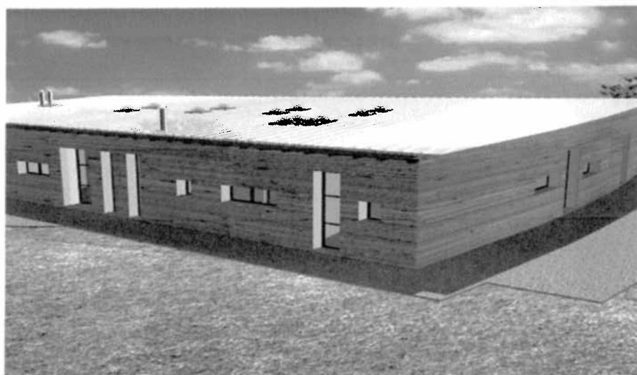
Nuovo Centro per l'Infanzia in Borgaro Torinese: Particolari facciate : Serramenti a doppia pelle, brise soleil in profilati metallici, rivestimento facciate in doghe di legno
